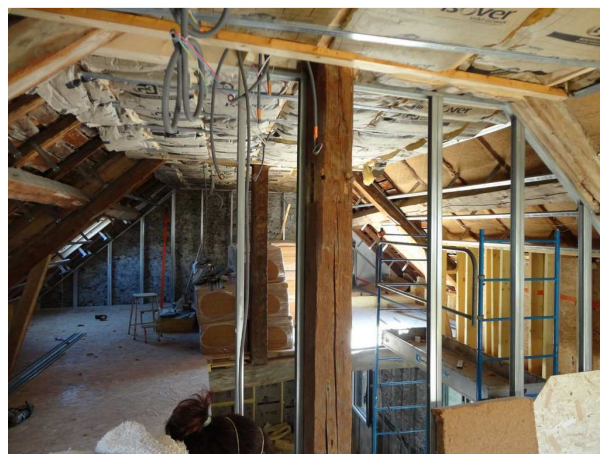
Pose d'isolation toiture et rampants
