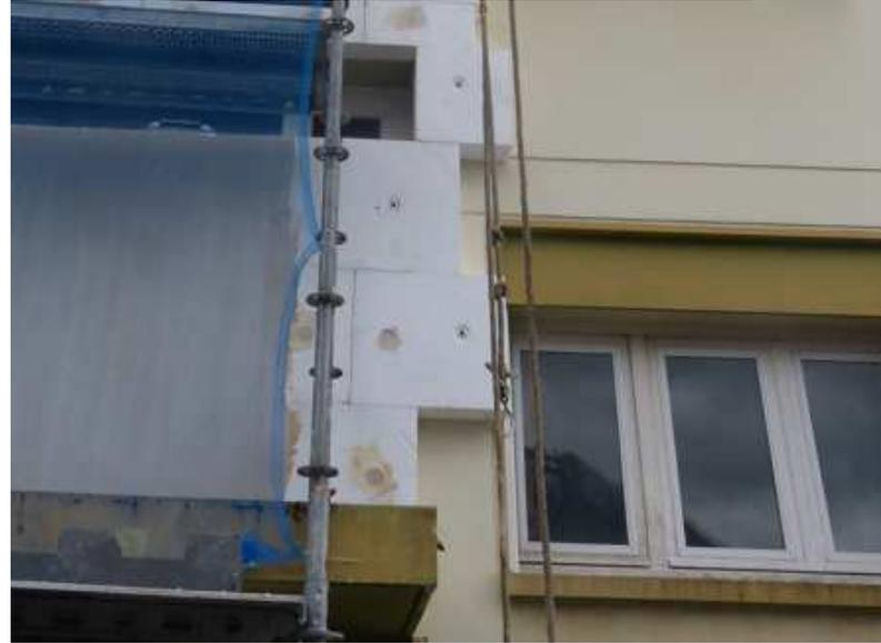
*Isolation en panneaux de polystyrène expansé*
