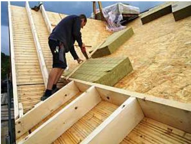
Toiture en pente : *Sous rampants*
