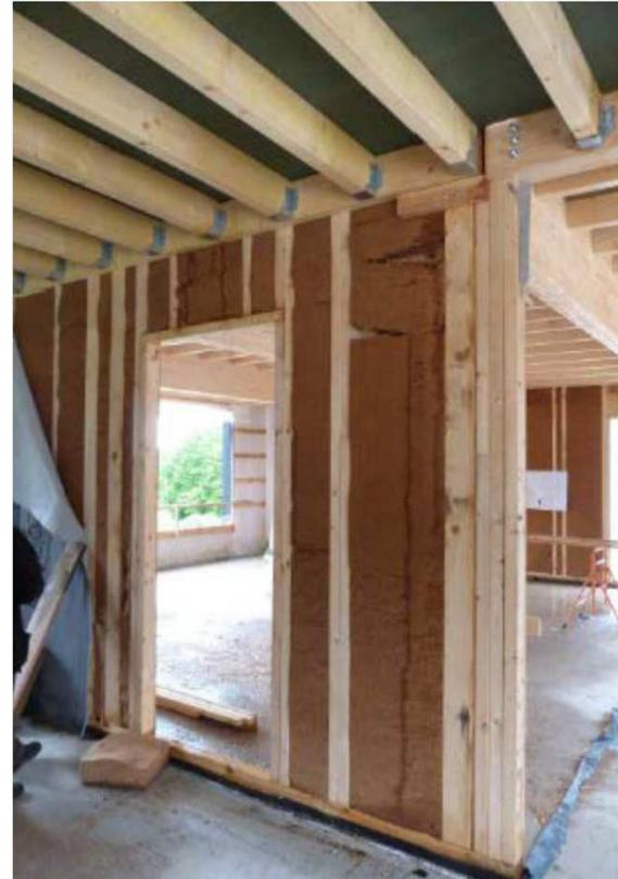
*Tassement de la fibre de bois suite à une arrivée d'eau en toiture en cours de chantier*
