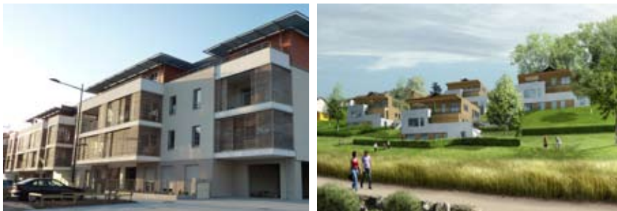
OPAC de la Savoie - Premiers logements sociaux BBC (Aix-les-Bains) et THPE (Le Montcel)
