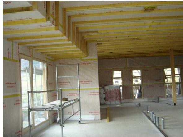
Traitement de l'étanchéité à l'air
